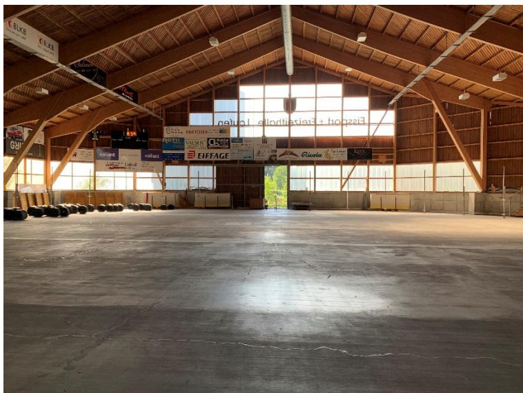
Abbildung 2: Innenansicht Halle gegen Osten
