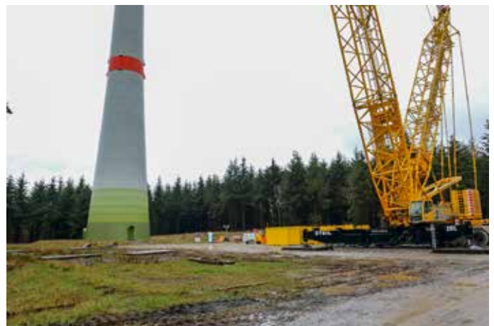
Bei Arbeiten an der WKA kommt ein Gittermastkran zum Einsatz, der die einzelnen Elemente in die Höhe hievt. AfW/Andreas Etter
