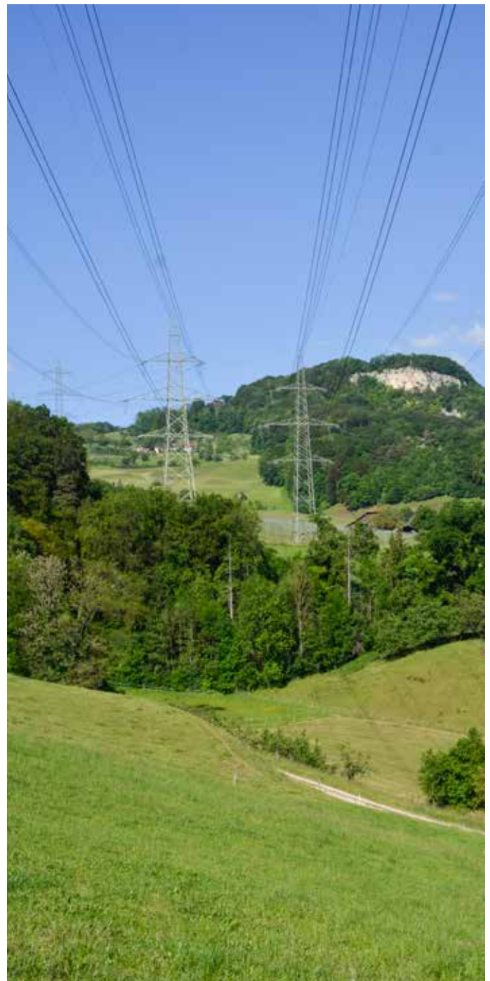
Zwei parallel verlaufende Hochspannungsleitungen der Swissgrid überqueren Feld, Wald und Flur in der Nähe der Sissacher Fluh. Foto hrl
