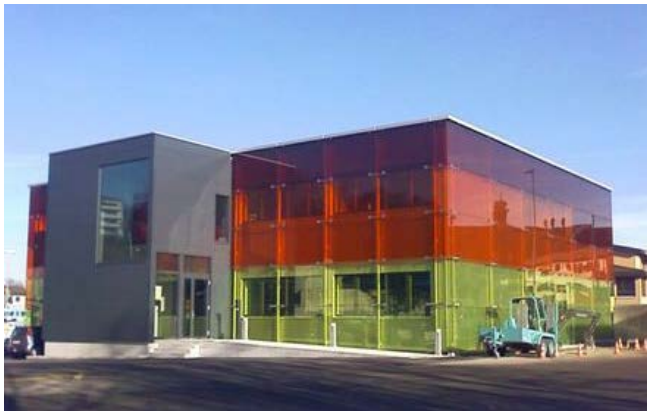
Abb.5: Das VMZ-Gebäude in Emmenbrücke (Quelle: ASTRA)
